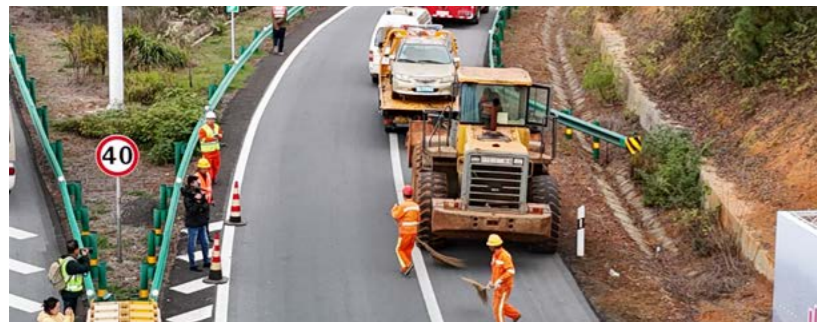
2024 年长韶娄高速公路边坡滑坡应急演练
