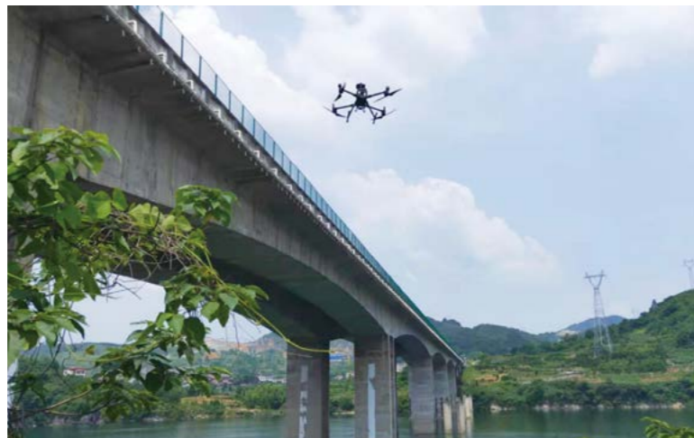
怀化分公司采用大疆无人机开展高速养护巡查
