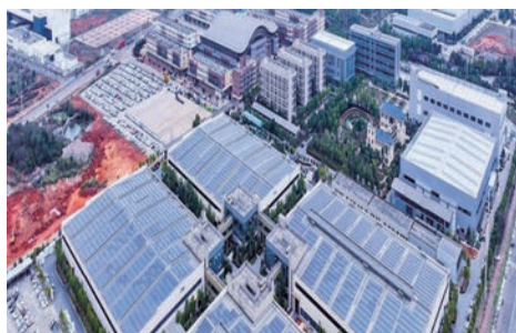
能源產業園廠房屋頂鋪設的分布式光伏板
