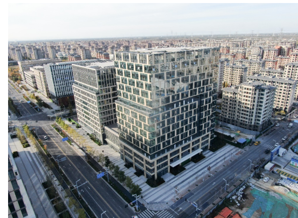
雄安容东片区一号地三标段项目
