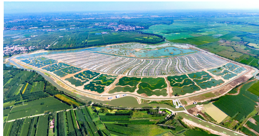
雄安新区府河河口湿地水质净化工程
