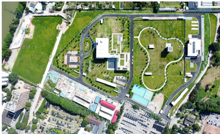
广州番禺桥南净水厂
