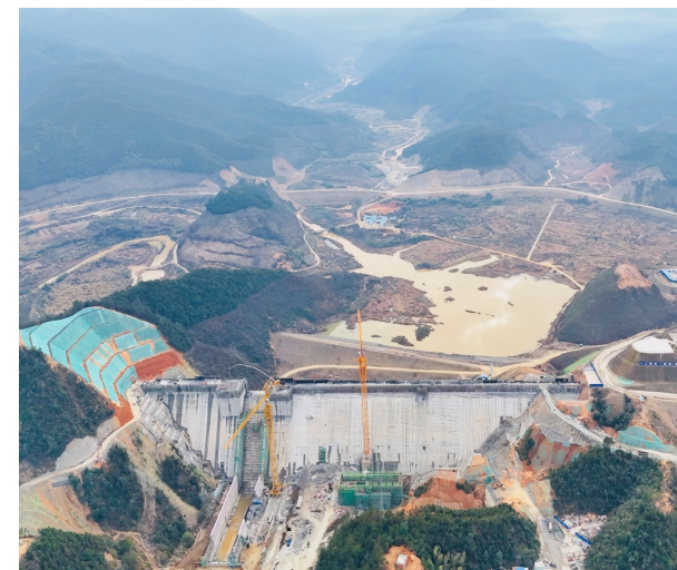
椒花水库工程
