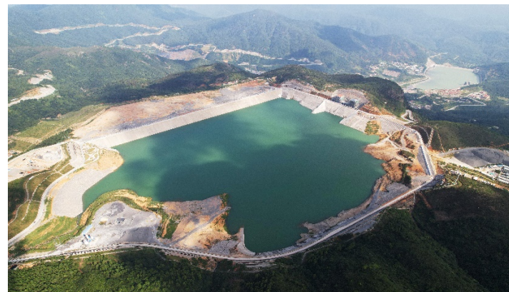
厦门抽水蓄能电站
