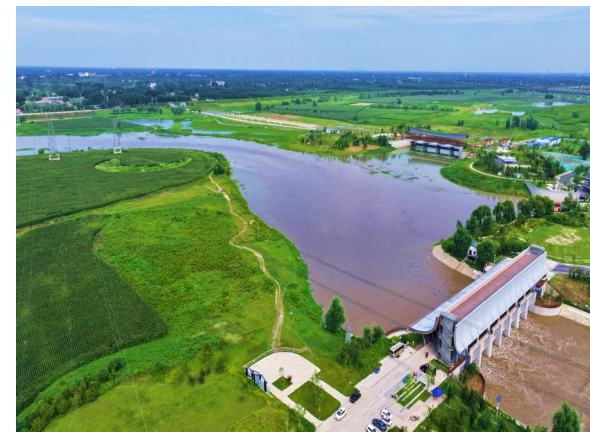
雄安新盖房枢纽改扩建工程
