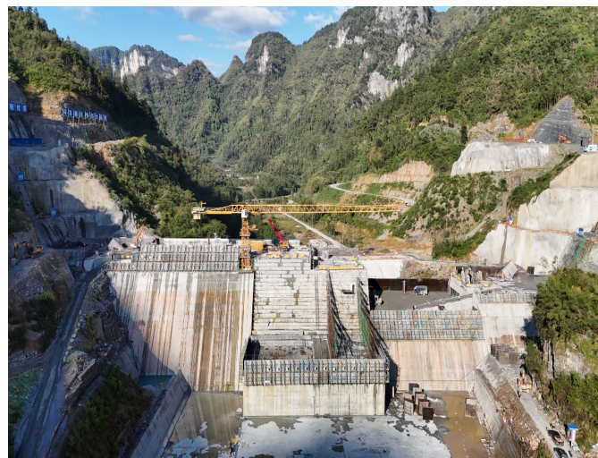
大兴寨水库工程
