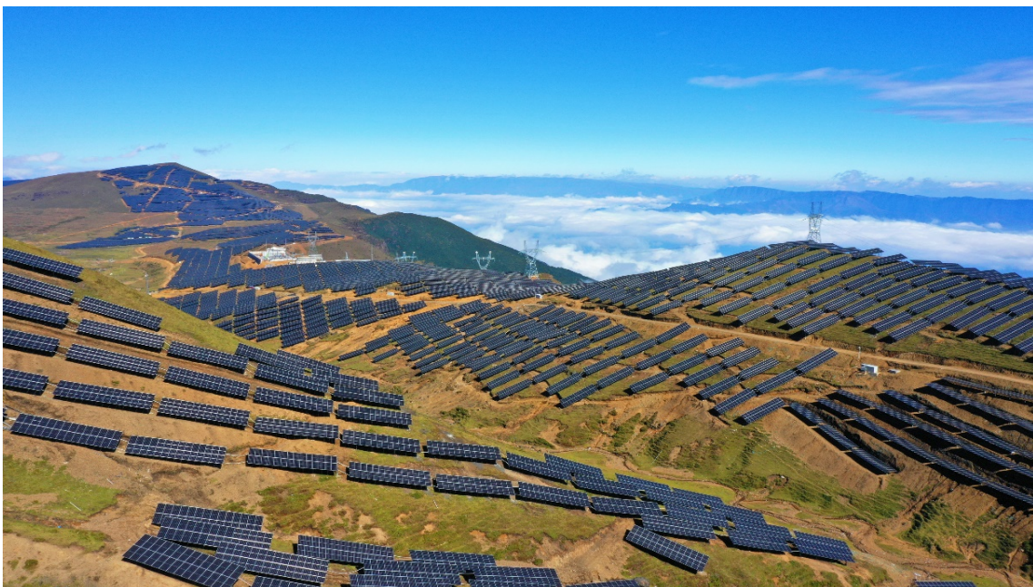
羊窝头65兆瓦光伏电站项目
