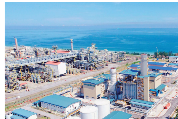
马来西亚凯德隆联合循环电站
