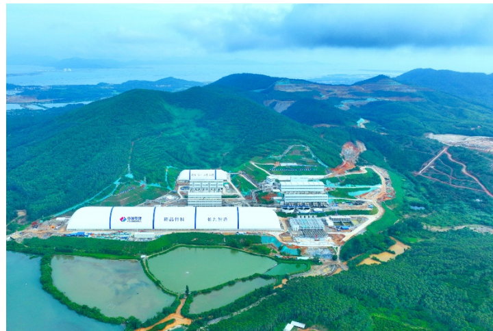
阳西麻岩矿砂石加工系统
