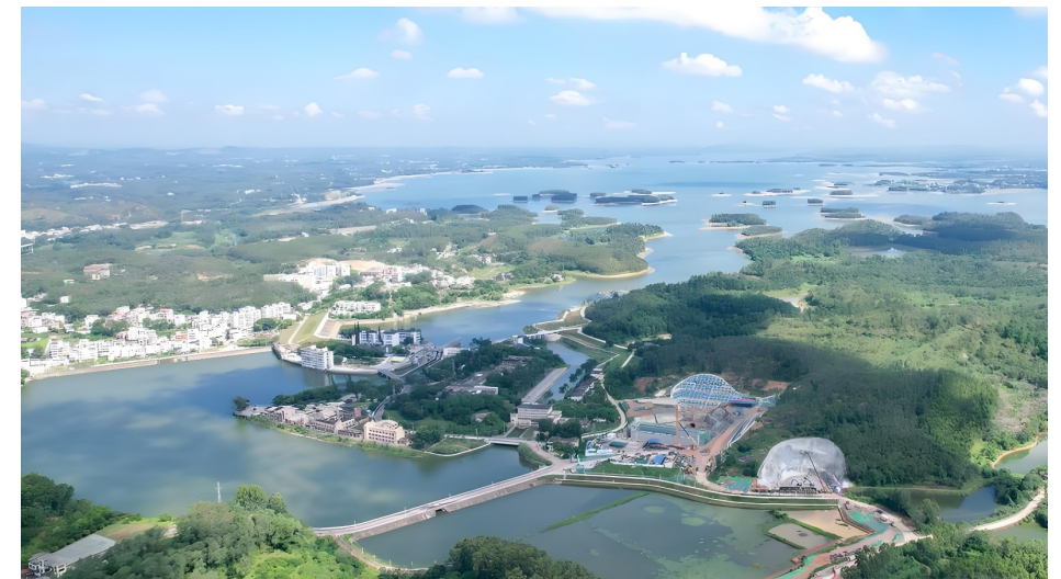
环北部湾广西水资源配置工程
