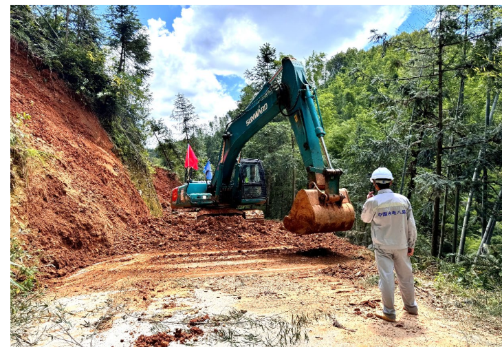
水电八局疏通灾区塌方堵塞道路
