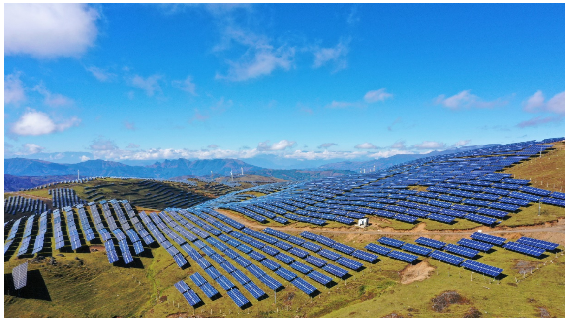
八棵树70兆瓦光伏项目
