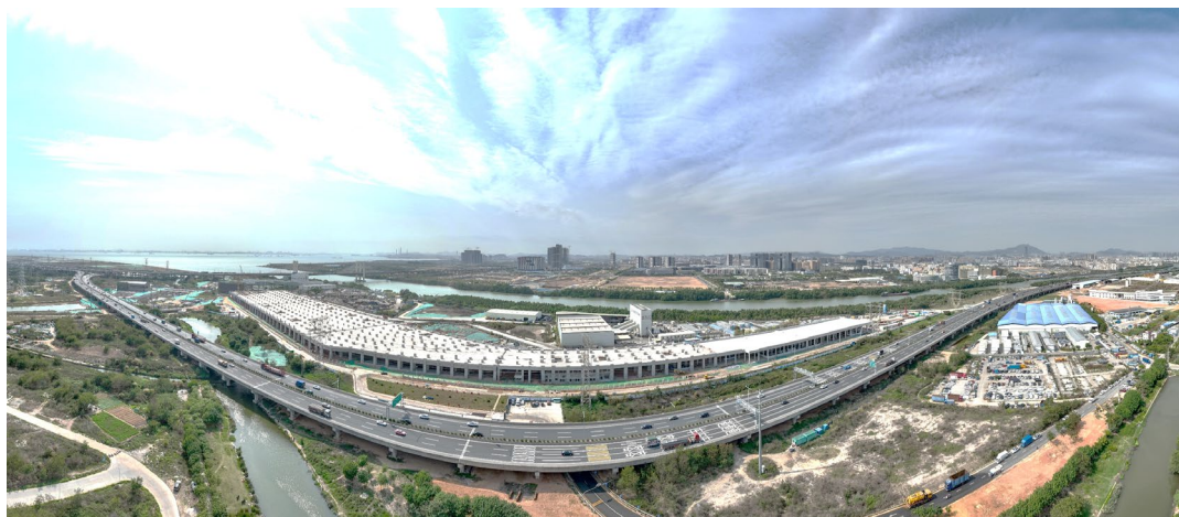
深圳地铁12号线二期工程
