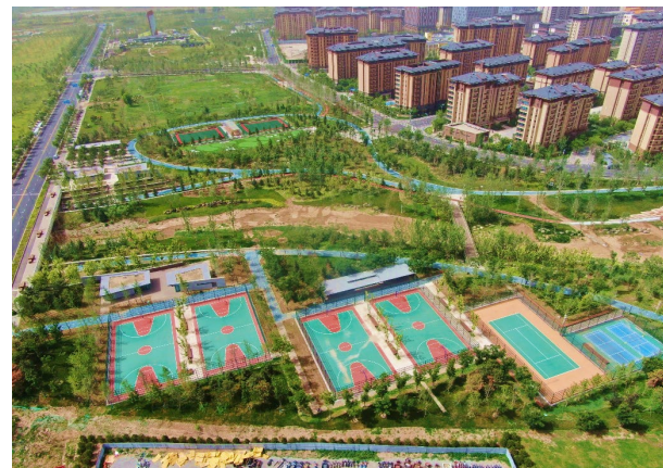
雄安容东片区体育公园项目
