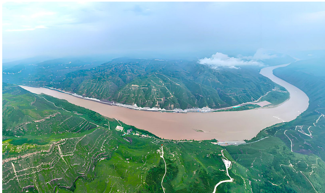
古贤水利枢纽工程
