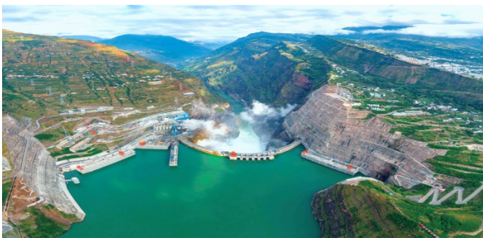
白鹤滩水电站
