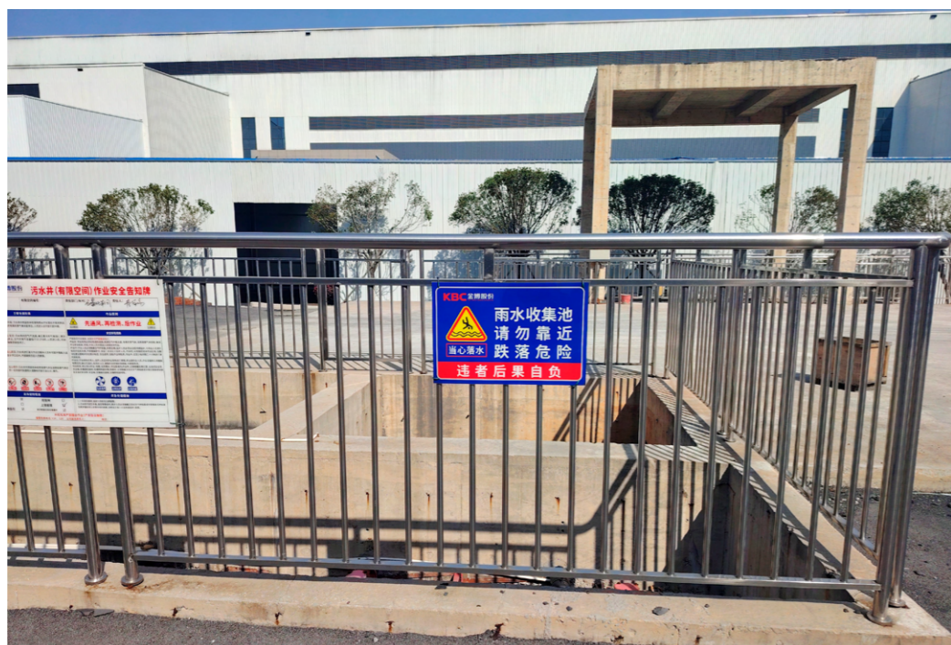
金博股份雨水收集池
