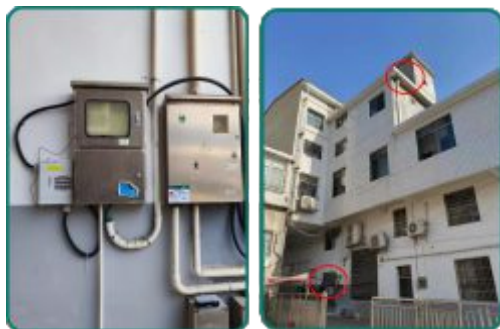
采用新装置避免打孔和长距离接线
