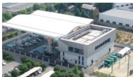
光、储、充协同控制示范点 ——榔梨智能充电站
